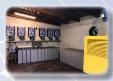
Los sistemas aislados son la solución ideal para disponer de energía en zonas sin conexión a la red eléctrica. Estos constituyen, por lo general, la posibilidad más económica de cubrir la demanda de energía en zonas retiradas. La energía producida por medio de módulos solares y generadores eólicos se acumula en baterías para que esté disponible cuando sea necesario.
